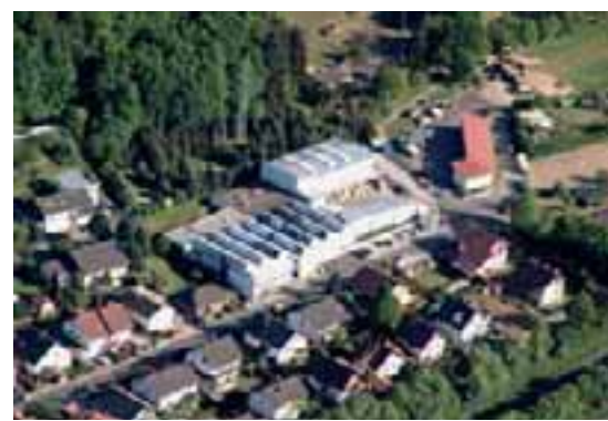
Das Betriebsgelände am Fuße des Spessarts wurde bereits mehrfach um- und ausgebaut.
