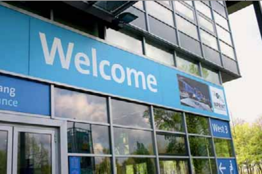
Die InPrint fand vom 8.-10. April in Hannover statt. Das Messegelände ist mit einer überdachten Fläche von rund 460.000 qm, einer Freifläche von 58.000 qm und 26 Messehallen das größte der Welt.
